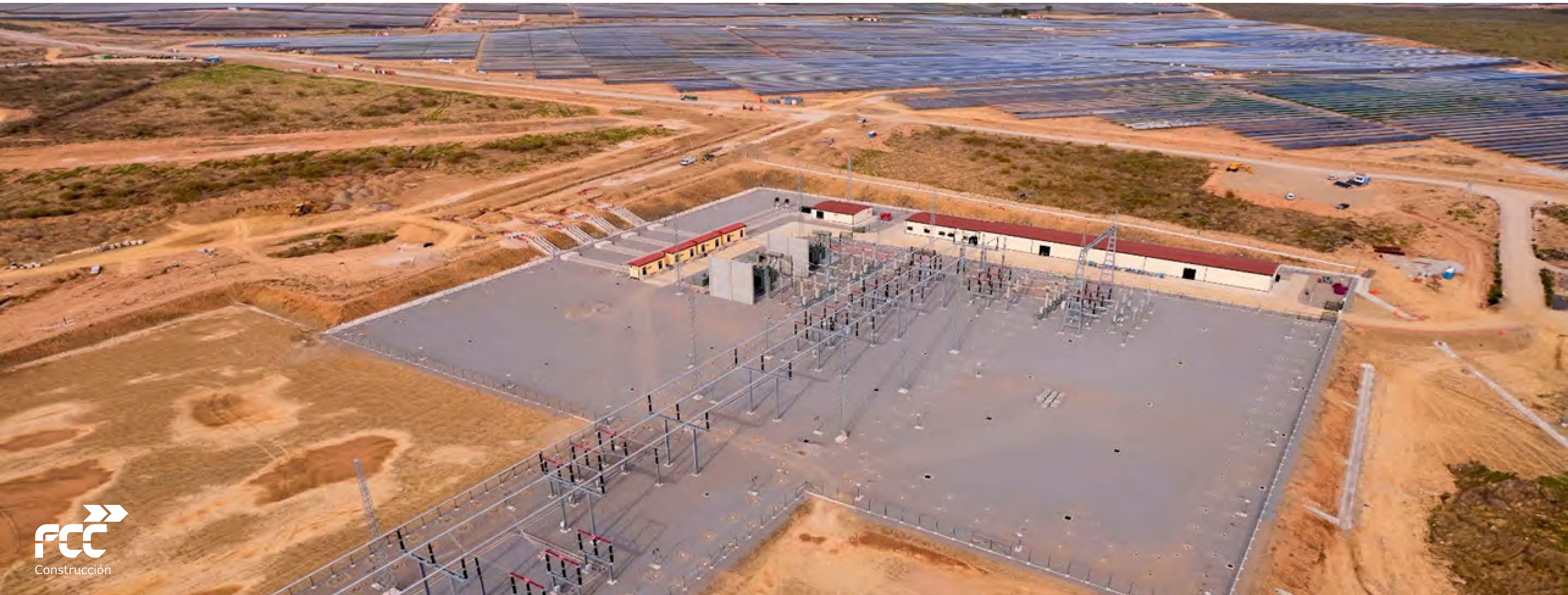
Planta fotovoltaica Pizarro, España
