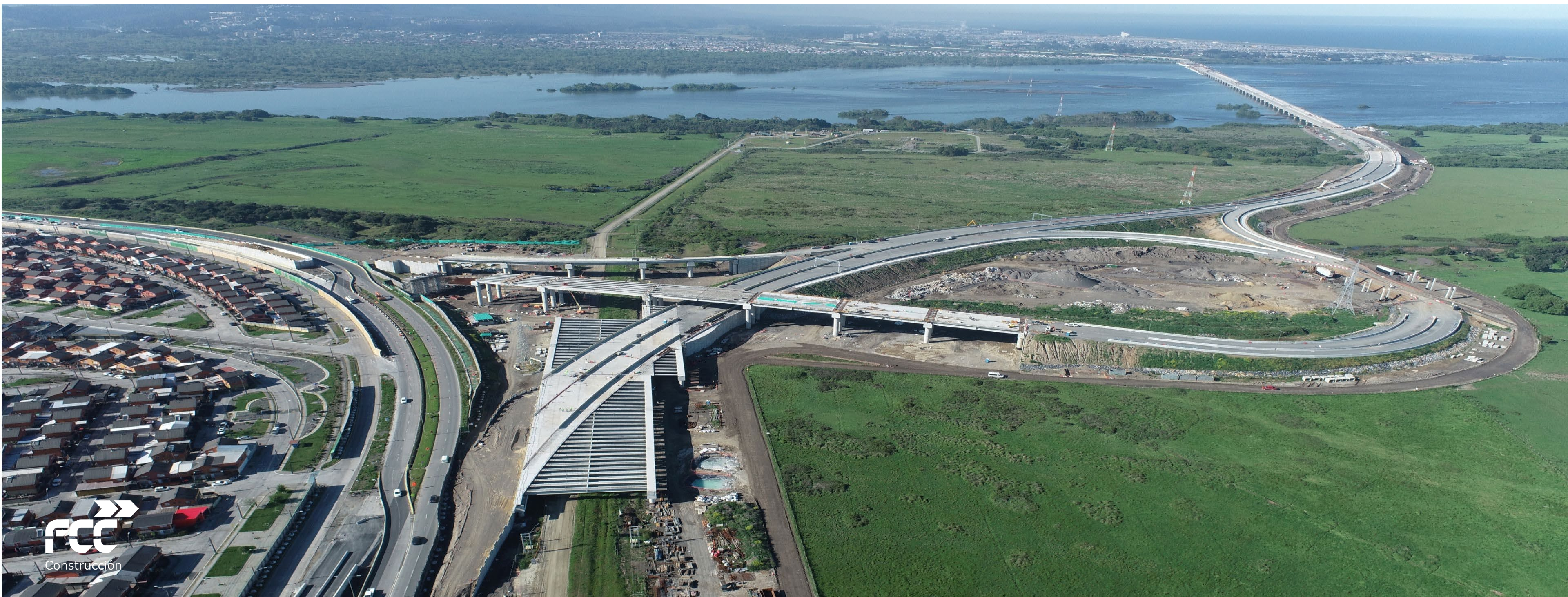
Puente Industrial, Chile
