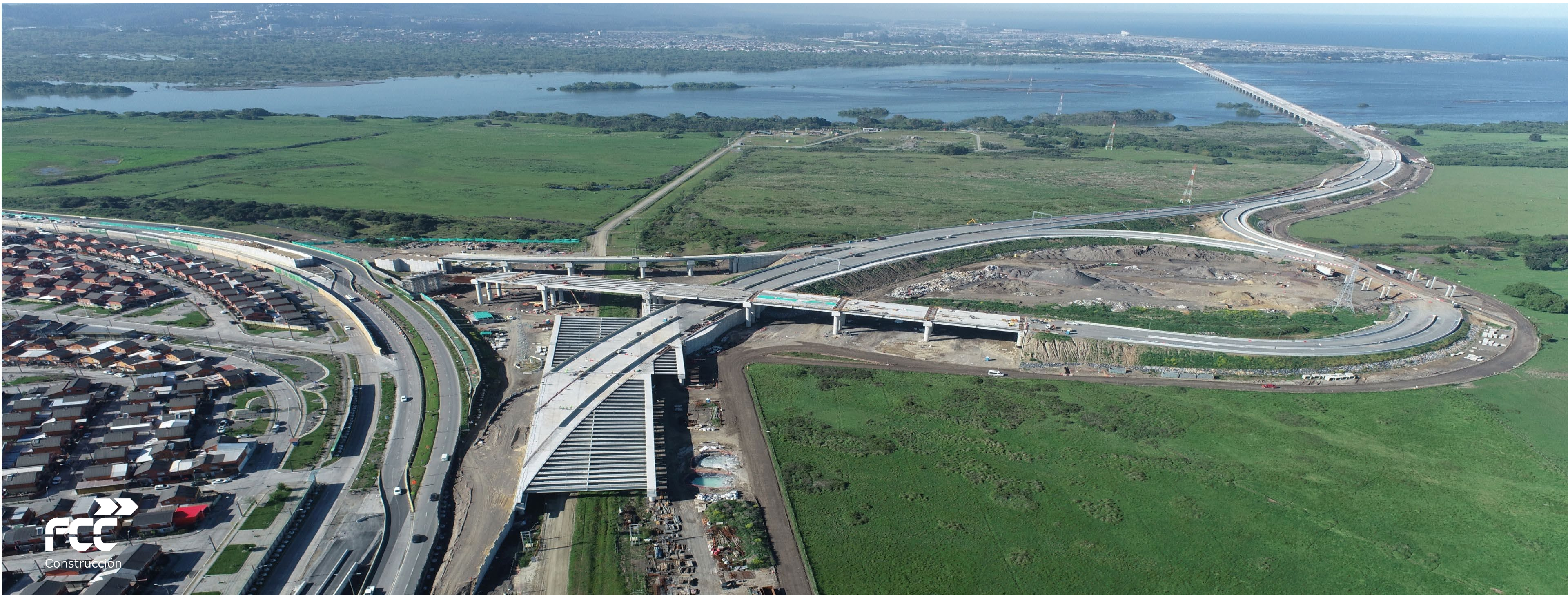
Puente Industrial, Chile
