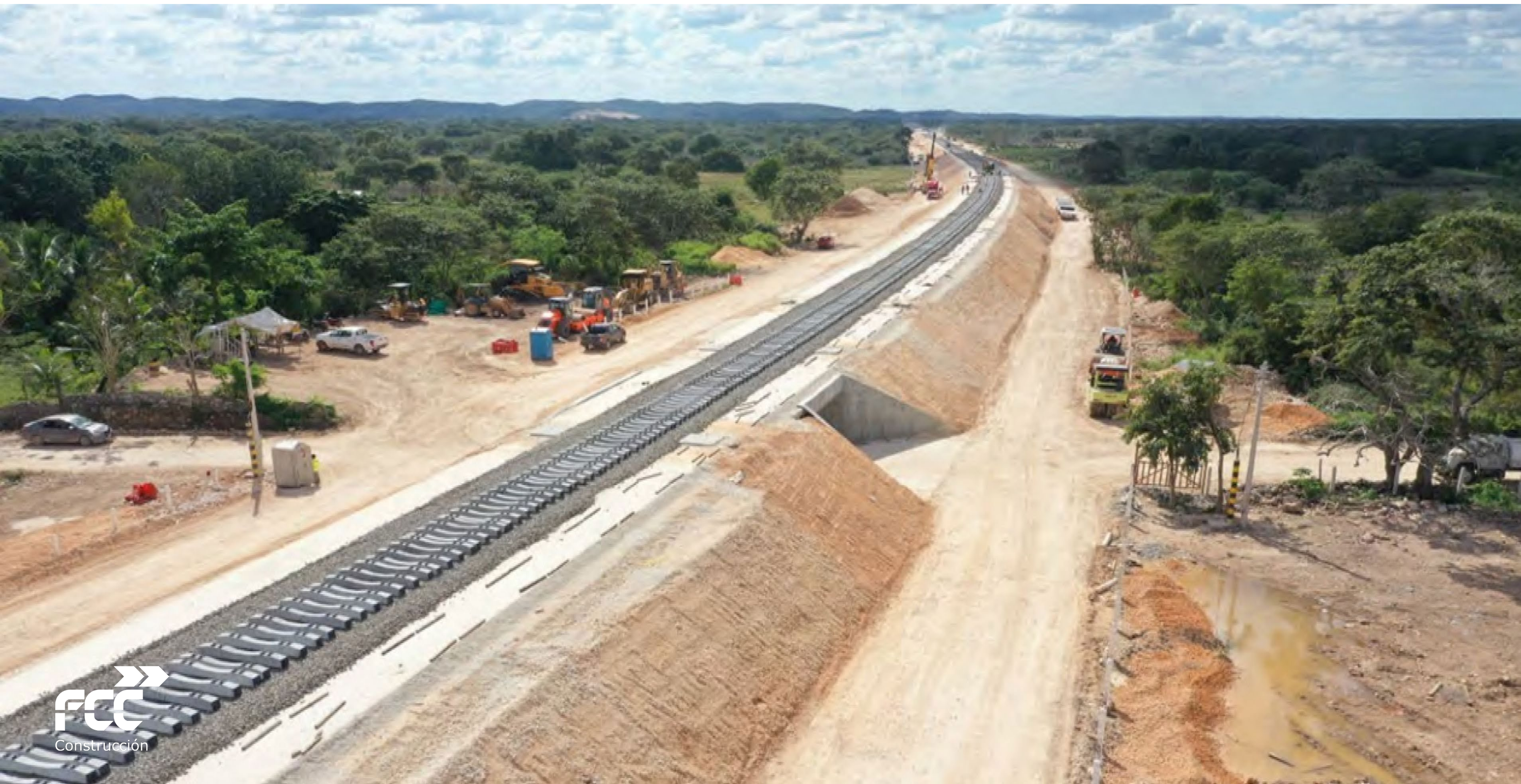
Tramo 2 Tren Maya, México
